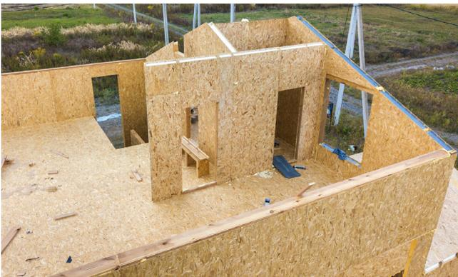
**Abb. 1:** Hausbau mit OSB-Platten
