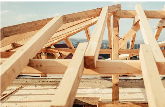
**Abb. 2:** Dachkonstruktion aus Massivholz
