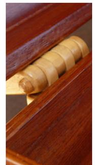
Abb. 34: Beispiel für ein Schlitz-und-Zapfen-Gelenk: Kofferscharnier aus Weißbuchenholz
