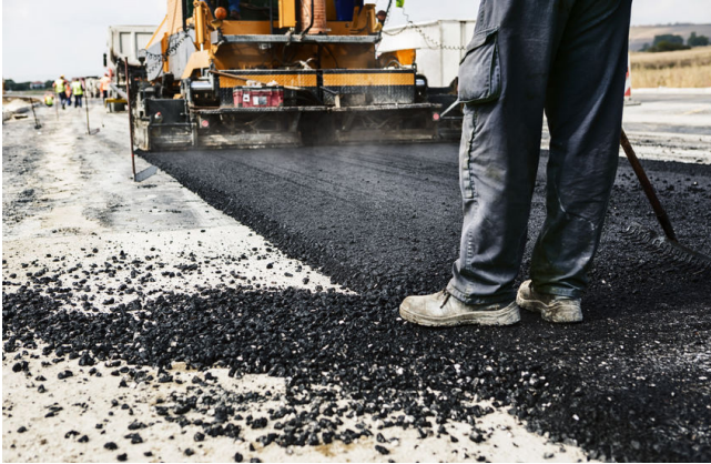
Abb. 3: Einsatz von Asphalt im Straßenbau
