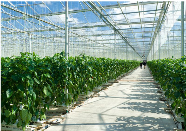
Abb. 34: Die Lichtqualität in einem Gewächshaus mit Acrylglas entspricht nahezu dem natürlichen Licht Quelle: © ClipDealer
